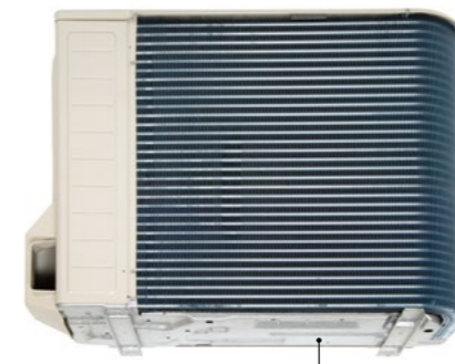
Seadmel puudub küttekabel ja põhi, kuhu koguneb sulatusvesi.
